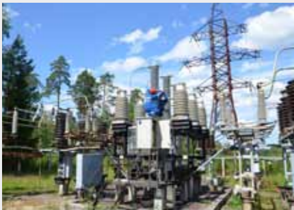
Шеф-монтаж вакуумного выключателя ВРС-110
