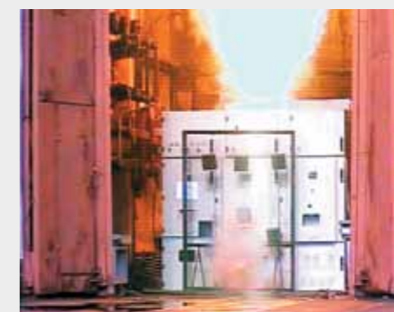
Испытание КРУ 10 кВ на локализационную способность
